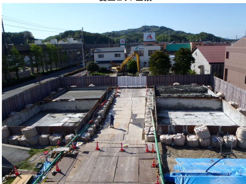
養生ピット全景
